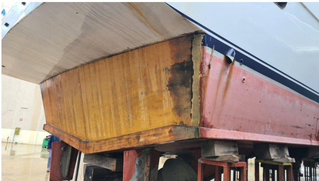
Figura 5 - 2 – Specchio di Poppa rifasciato/riparato
