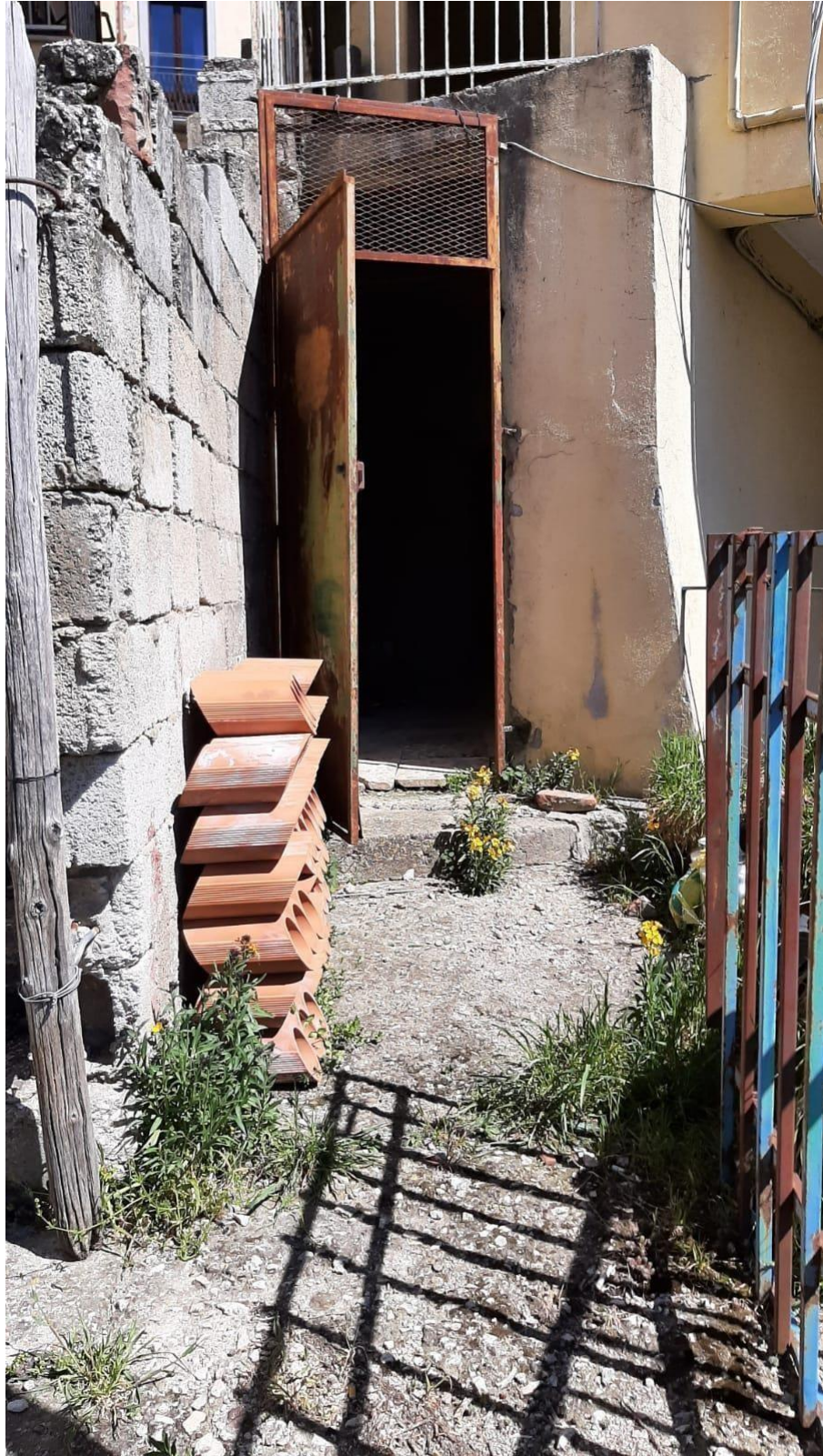
Figura 8- Locale e deposito
