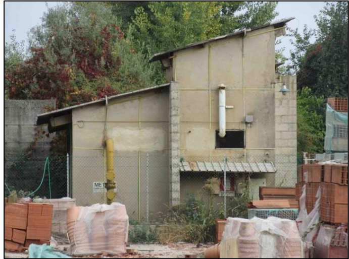
cabina gas metano
