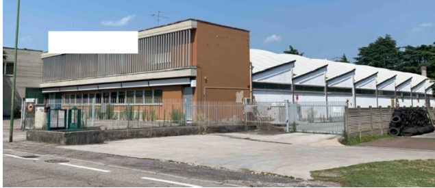
Vista generale del capannone
