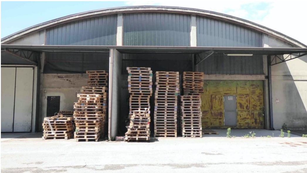
Vista del prospetto principale
