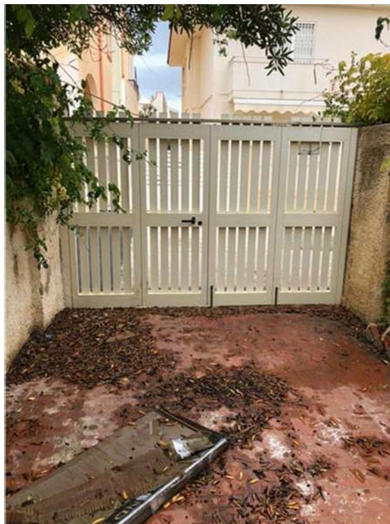
Figura 35 - Corte di ingresso al fabbricato
