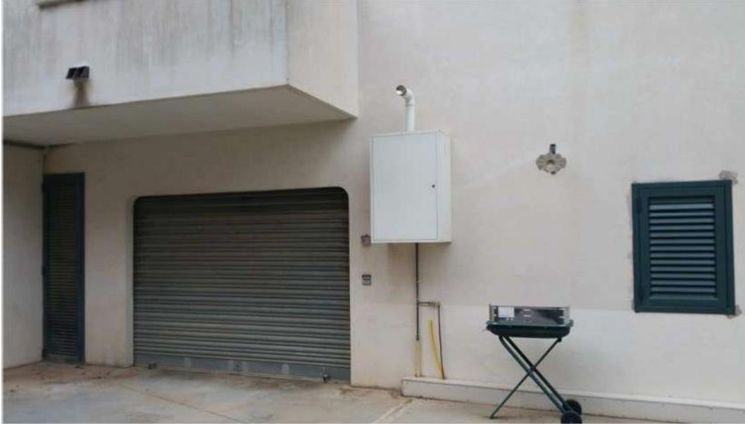
Figura 14 - Accesso al garage
