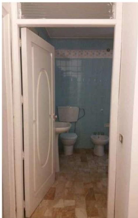
Figura 25 – WC (zona sud)
