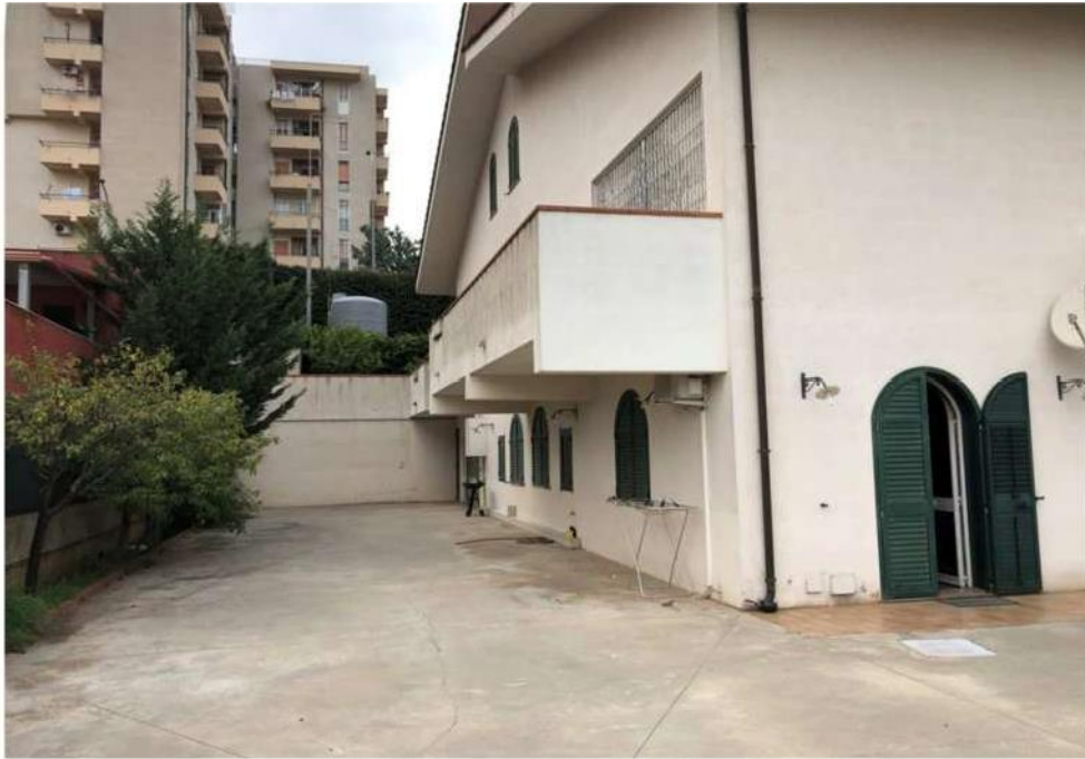
Figura 8 - Accesso all' immobile in Via Cupolette
