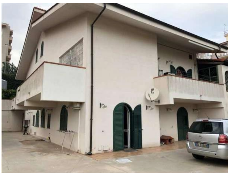
Figura 3 - Porta finestra di accesso al piano terra
