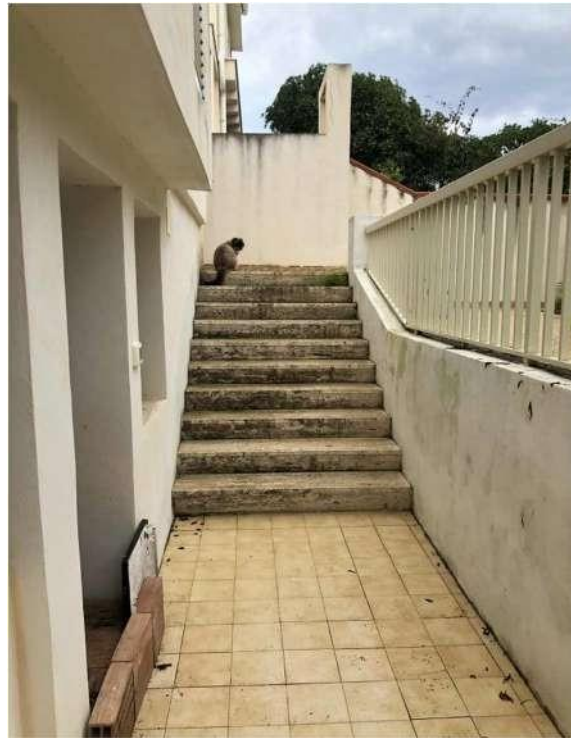
Figura 37 - Corridoio esterno di accesso al fabbricato
