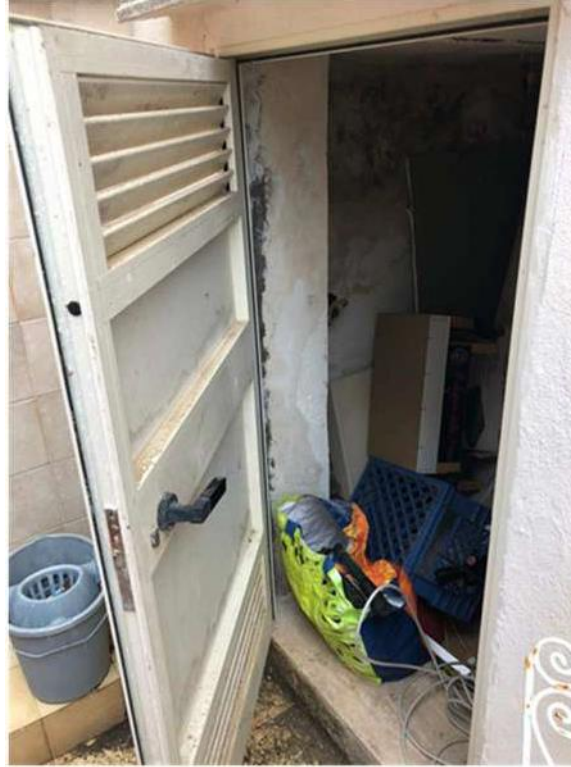
Figura 36 - Ripostiglio con accesso esterno
