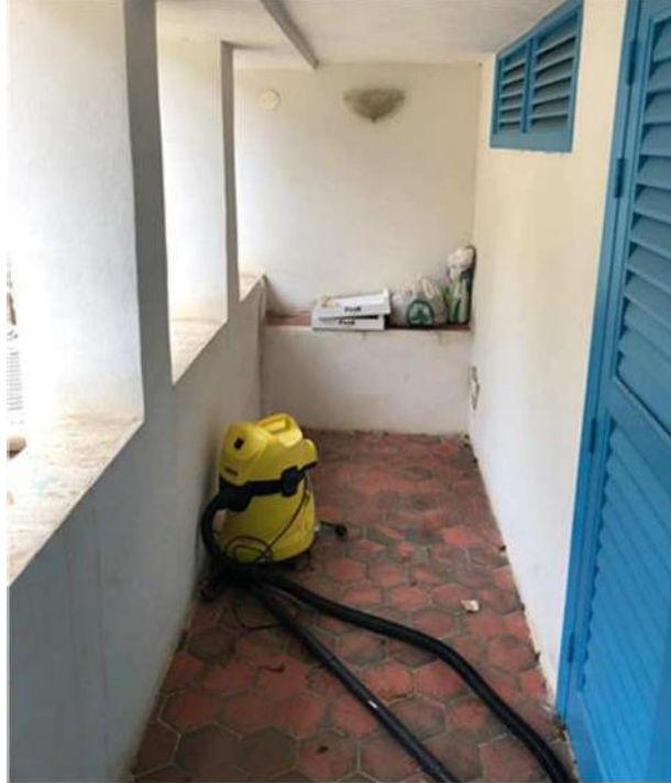
Figura 38 - Corte interna al fabbricato
