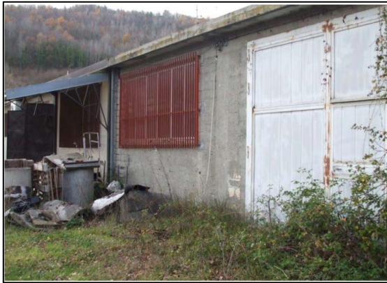
depositi-mensa-spogliatoi-wc lato est
