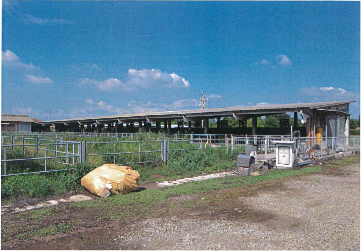
Veduta della stalla principale (tettoia a copertura della corsia di alimentazione e paddock)
