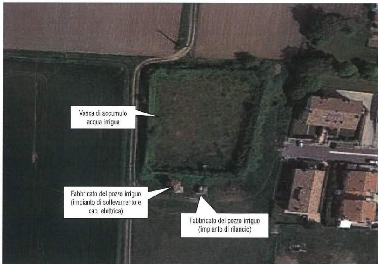
Veduta aerea dei due fabbricati a servizio del pozzo irriguo e del terreno circostante con vasca di accumulo
