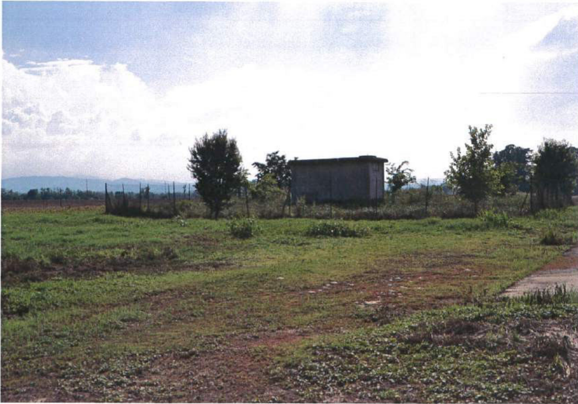
Veduta esterna del fabbricato del pozzo idropotabile
