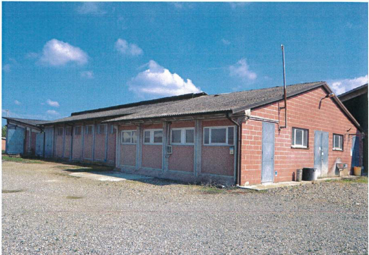
Veduta esterna del fabbricato ove si trovano la sala mungitura e la sala latte a servizio della stalla principale
