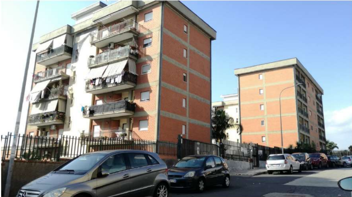
Via Pietro Nenni – vista del complesso "La Rinascita"
