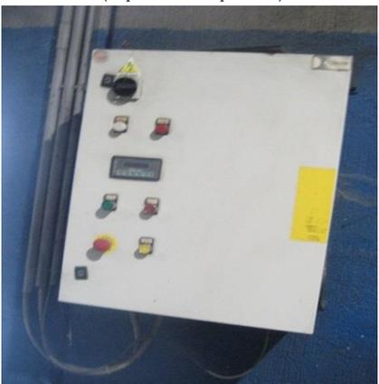
QS Quadro Sist. Ventilat. Saldatura
