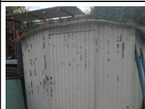
#46: Baracca de Obra en Chapa - A
