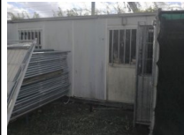
#44: Caseta de Obra
