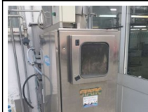
#36: Instalación Hidrolimpiadora Blue Clean 1230
