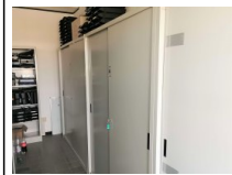
#36: N. 12 Metal Cabinets
