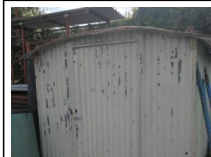
#46: Työmaarakennus peltinen - A
